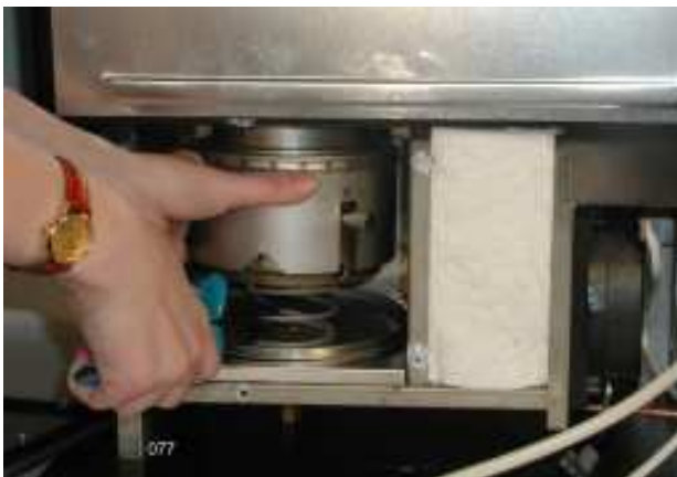
Bilde 11: Løsning av brenneren.
