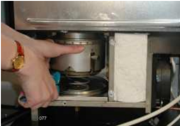
Kuva 11: Poltinkokonaisuuden irrottaminen.
