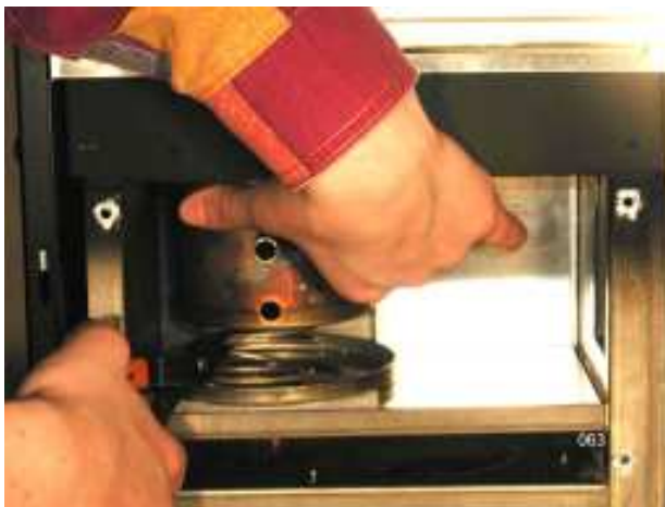
Bilde 11: Løsning av brenneren.
